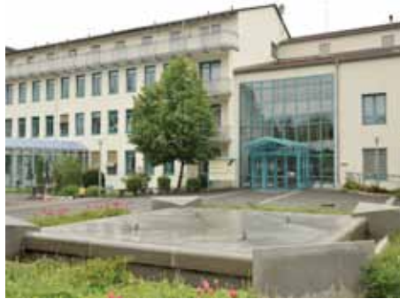
Die Juraklinik in Scheßlitz erneuert ihre Energiezentrale mit einem modernen Blockheizkraftwerkes
